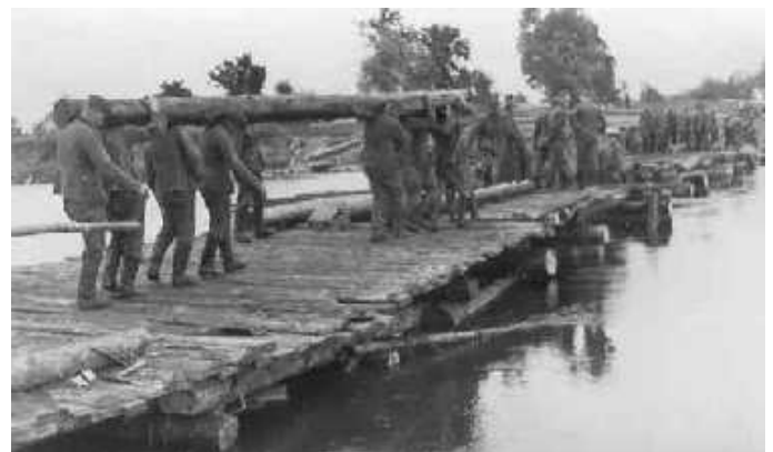
Bau einer Brücke durch das Pionier-Bataillon 80
